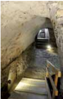
[ Passaggio sotterraneo Underground passage
